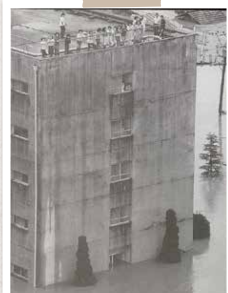
▲ 5階建ての1階部分が完全に水没した三洋住宅
