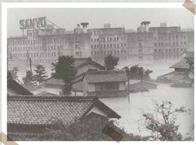
▲ 破堤後なおも降り続く雨にけむる三洋付近
